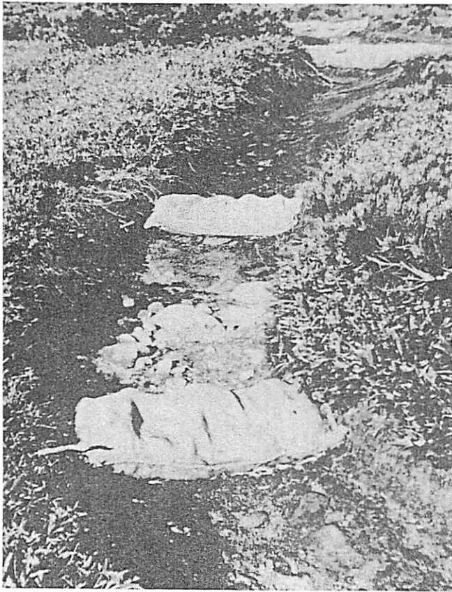
細い線状裸地に階段状に設置した 麻袋工。上流より⑤、⑥
