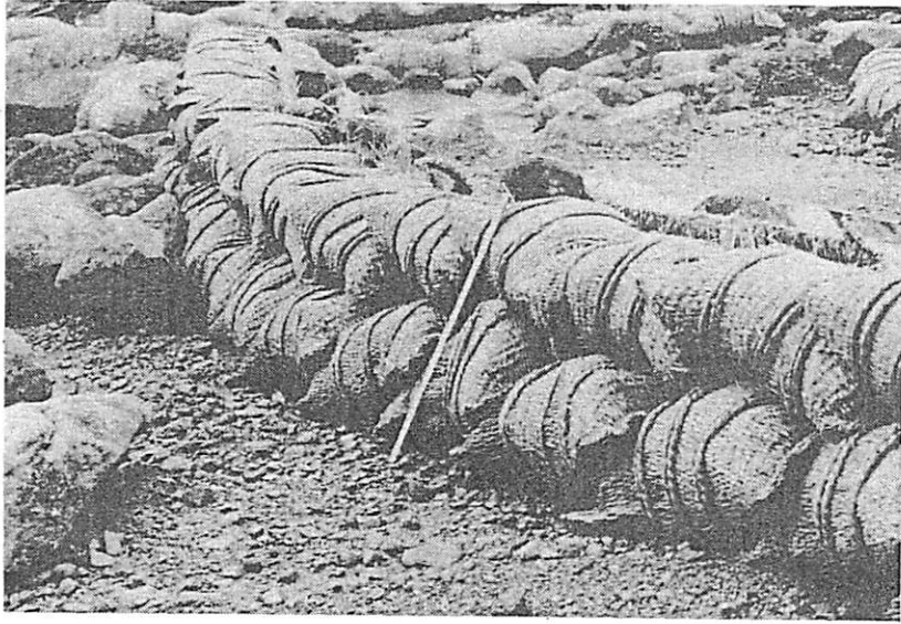
2 段にした積工
