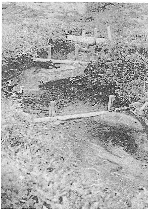
最下流の板柵工が傾いているのが見える。
