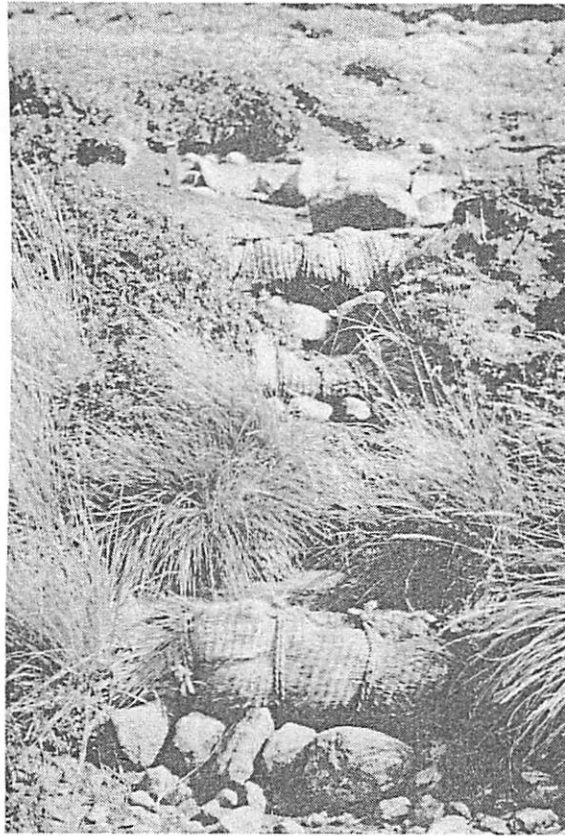
土砂段差型の裸地に階段状に設けたむしろ籠工 下流より
