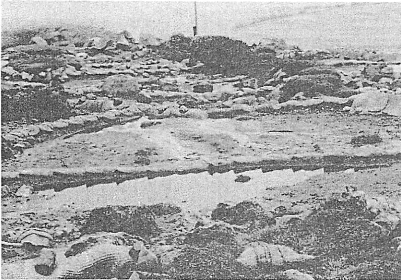
豪雨後の工事現場、列間は石礫 を採取したので積工への土砂の 堆積が顕著である。
