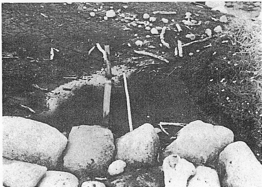
写真2 施工地No.1 堆積土砂がほぼ満砂状態となっている。 (昭和55年6月撮影)
