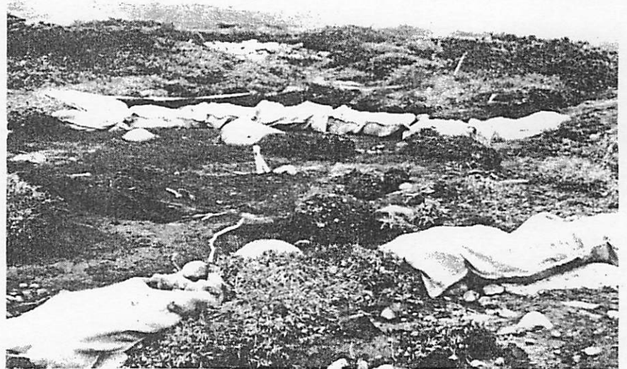
写真46 54年度実験施工区 麻袋工
