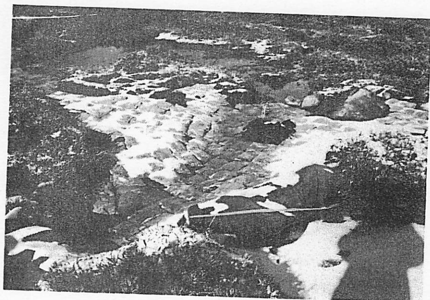
写真58 植生袋工施工後 (昭和54年10月撮影)
